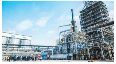
家以针状焦、重芳烃生产经营为主营业务的股份制企业,30万吨/年针状焦 原料预处理装置及相应公用工程配套设施已于2015年底建成,于2016年3 月份投产,10万吨/年针状焦联合装置及相应公用工程配套设施于2017年 7月建成。项目总投资6.6亿元,项目全部投产后可实现销售收入35亿元。
