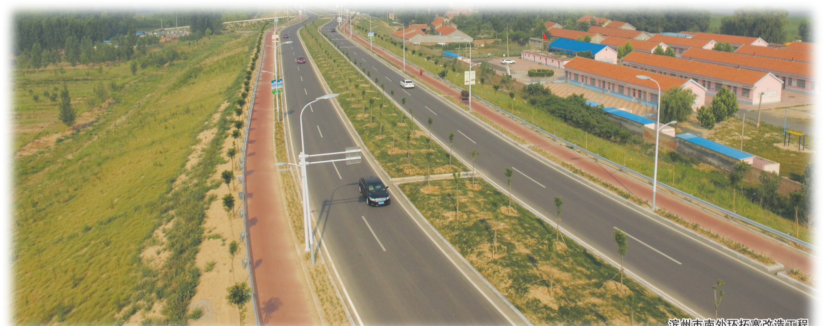
滨州市南外环拓宽改造工程
