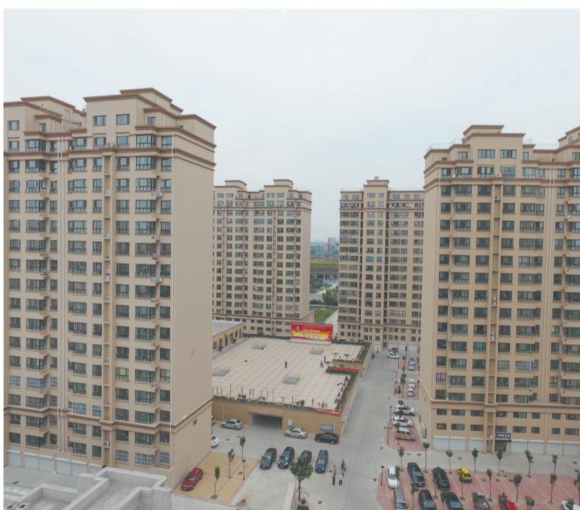
市东街道居民安置小区桃李幸福家园。
