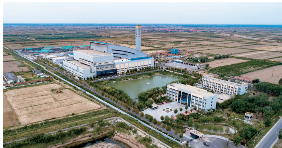
滨州生活垃圾焚烧发电项目(国优工程) 摄影:赵利军
