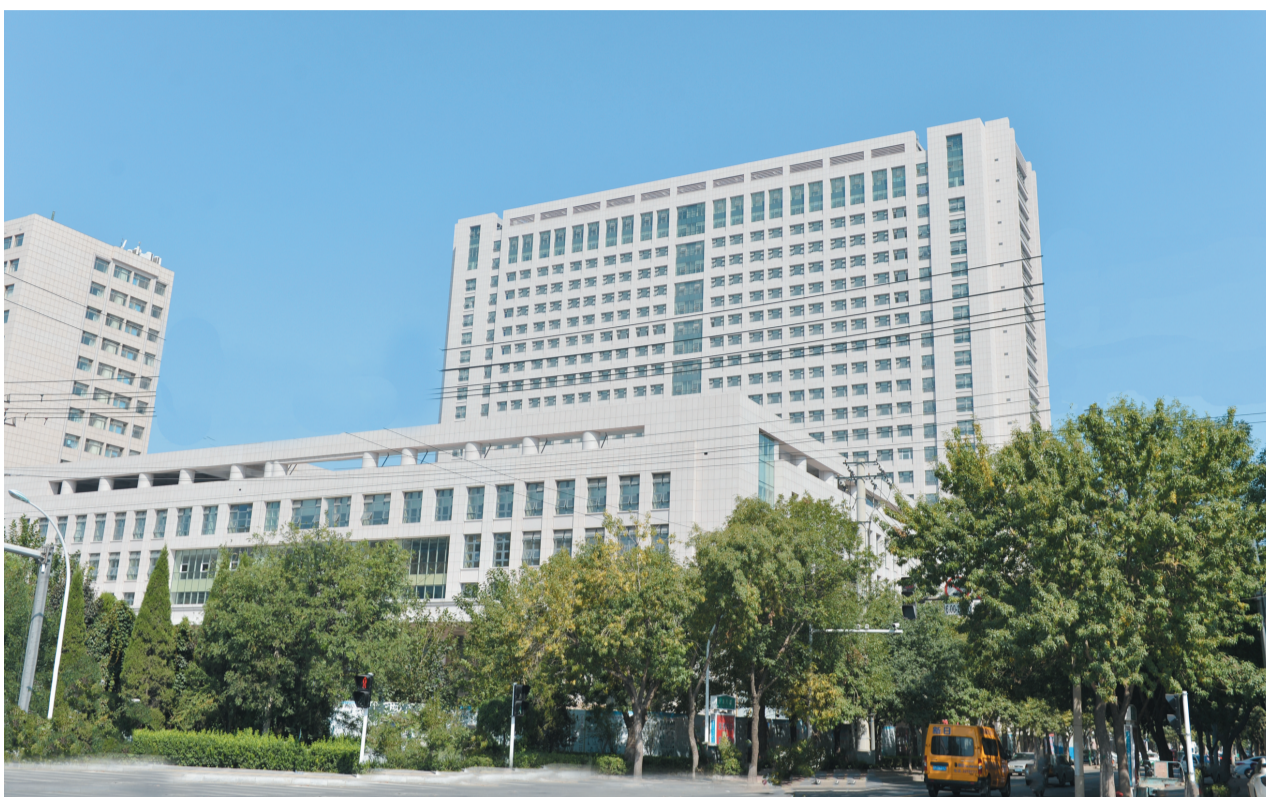
即将竣工的门诊医技病房综合楼
