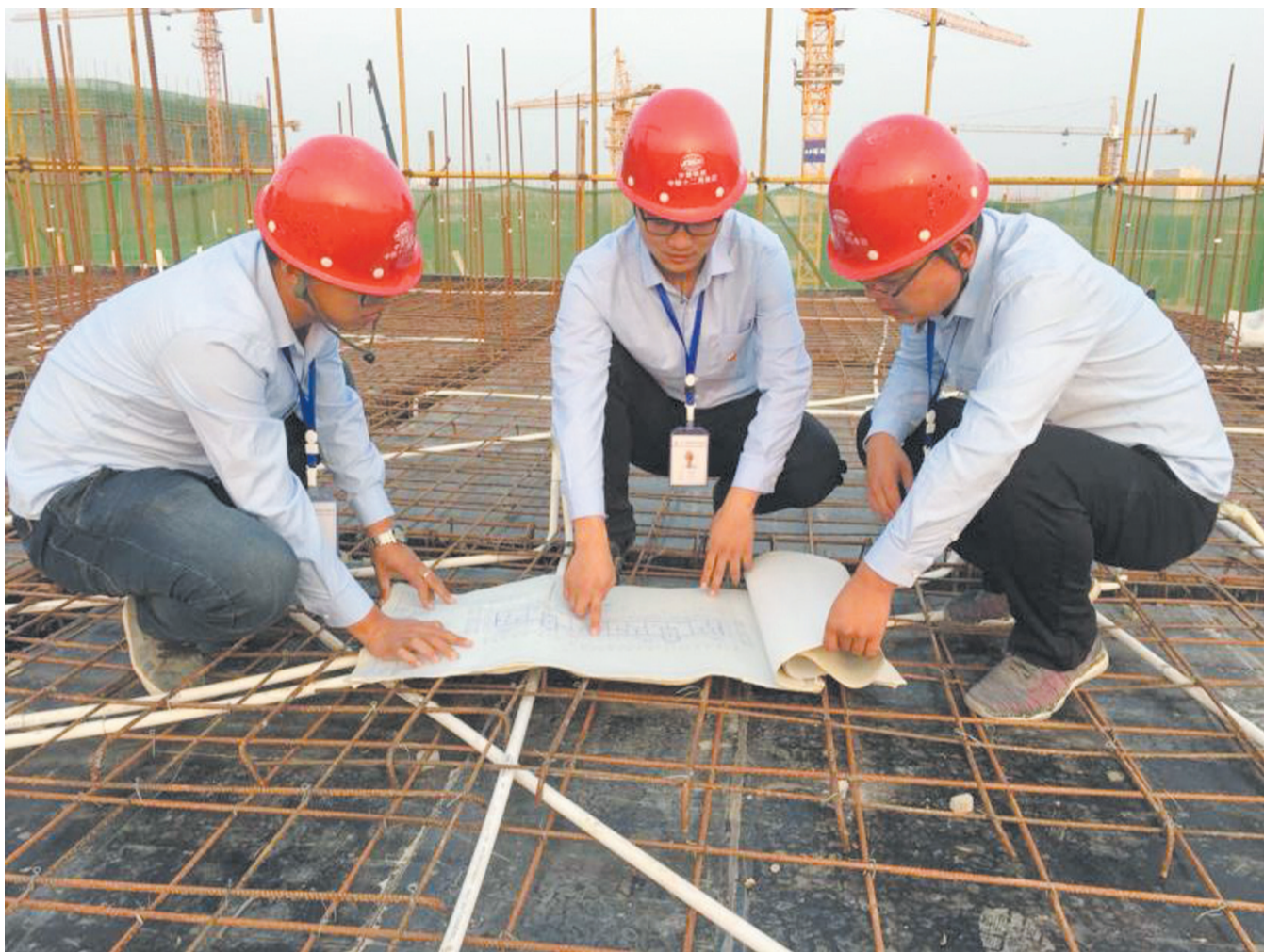
北鄞社区建设项目总工程师姜靖涛(中)在项目现场指挥。
