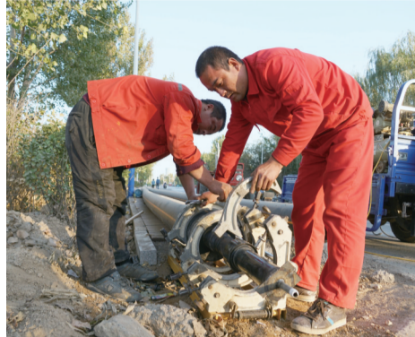
铺设外网管线。
