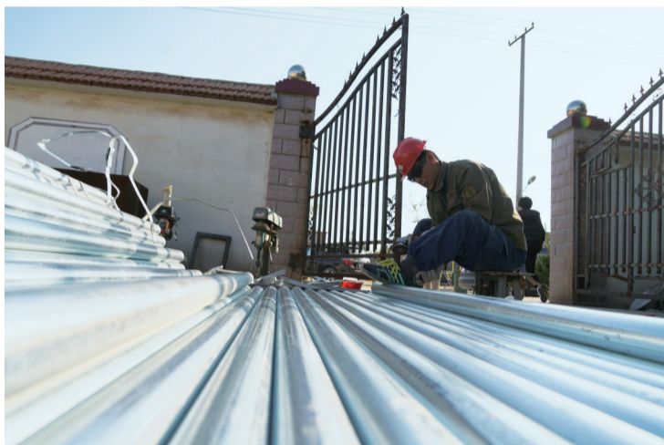
在开发区,清洁取暖改造工作正在全力推进。
