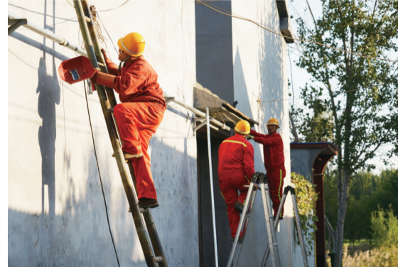
在村内架设天然气管道。
