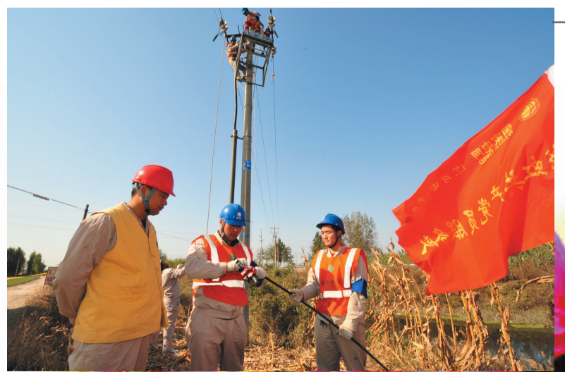
滨州供电公司“彩虹党员服务队”加紧建设10千伏线路。
