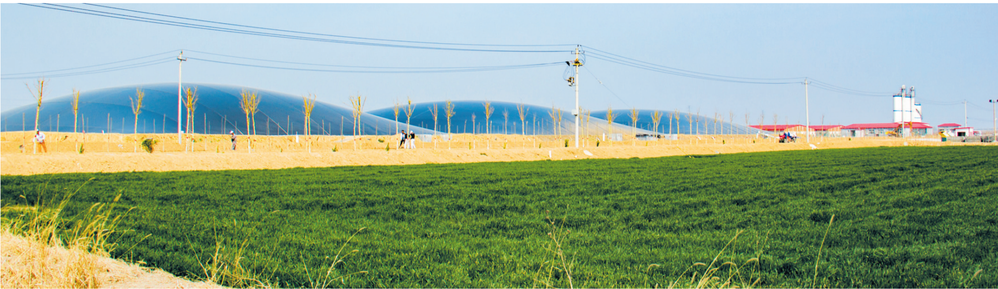
大型沼气设施。
