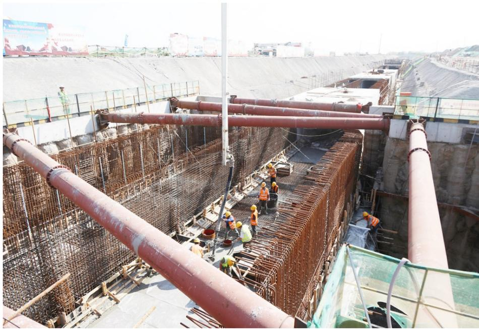
滨州日报/滨州网讯(记者 樊飞 李前军 通讯员 张秀华 报道)5月30日,记者在北海经济开发区地下综合管廊工程施工现场看到,几米深的地下钢筋林立,工人们施工秩序井然。据介绍,600名工人正在同时施工,他们为热力、给水、中水、通讯、电力五种管线在地下“安家”。
