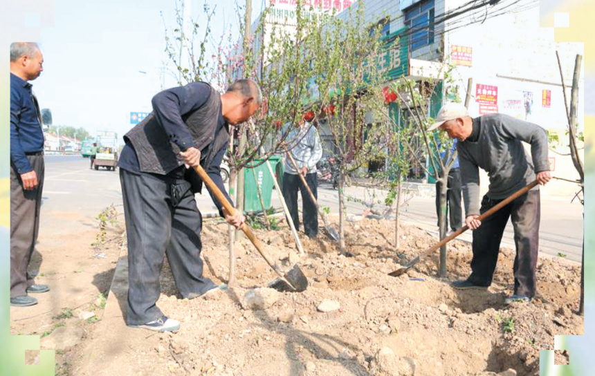
实施道路绿化工程。
