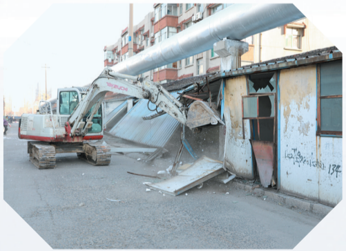
拆除违章建筑。
