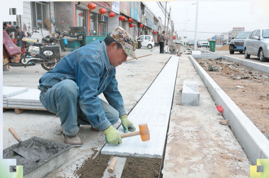
实施会仙二路高新段道路亮化工程。
