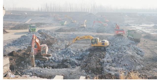
近日,笔者在惠民县樊桥闸除险加固工程施工现场看到,施工人员正加紧施工中。截至目前,旧闸已全部拆除,导流渠、上下游围堰建设完成,正在进行排水工作。该工程是山东省灾后重点防洪减灾工程建设重点项目,批复总投资5870万元,已于1月2日正式开
