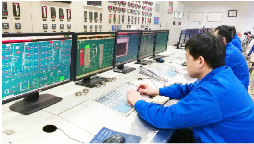
滨州高新区供热中心扩建工程项目
