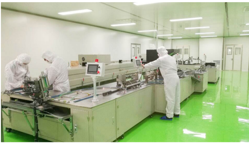
如悦医疗科技有限公司-医疗净化车间项目
