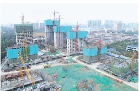
碧桂园·翡丽之光在建项目航拍。
