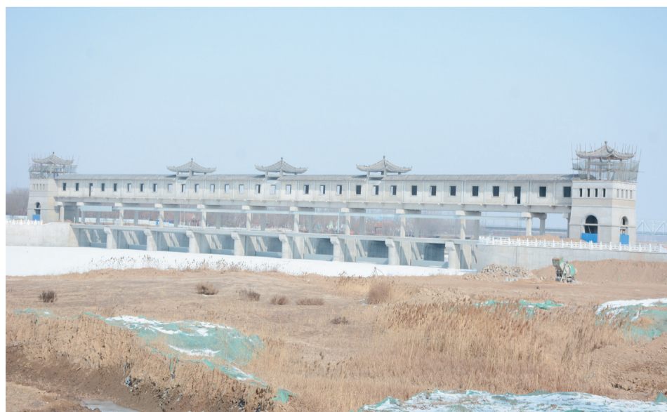
新建完成的徒骇河节制闸。
