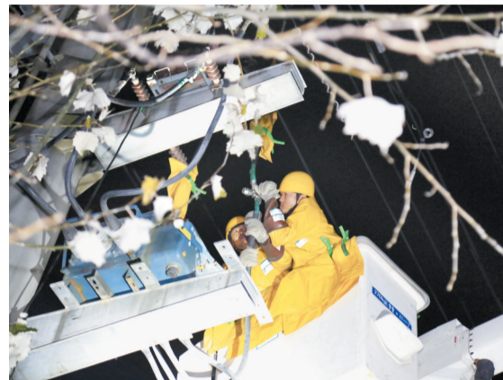
国网滨州供电公司彩虹共产党员服务队连夜修复发生故障的联络开关。
