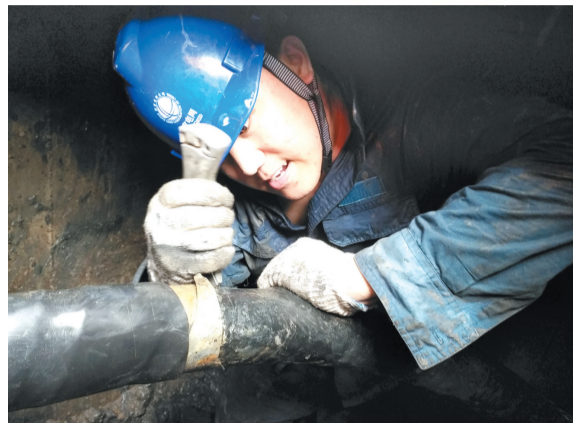
国网滨州供电公司彩虹共产党员服务队队员在电缆井内修复电缆故障。
