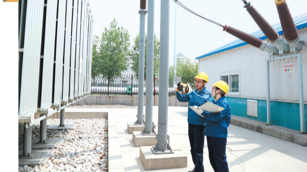
国网滨州供电公司员工在110千伏伏化变电站为1号主变测温。
