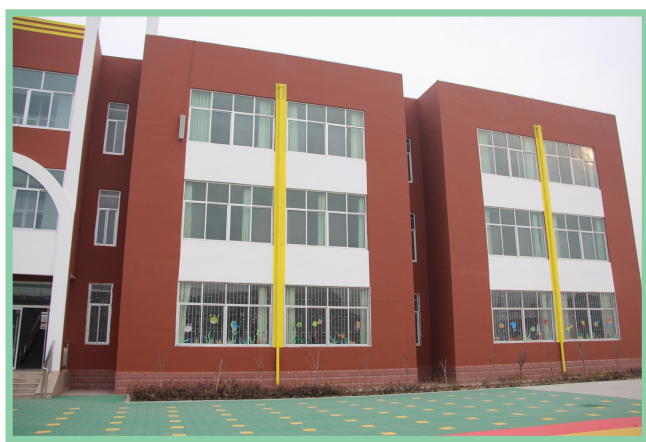
沾化区冯家第二实验学校综合楼改造项目
