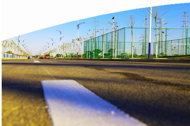
持续加强基础设施建设,黄河十三路全线贯通,黄河十四路秦台河桥墩全部浇筑完成。
