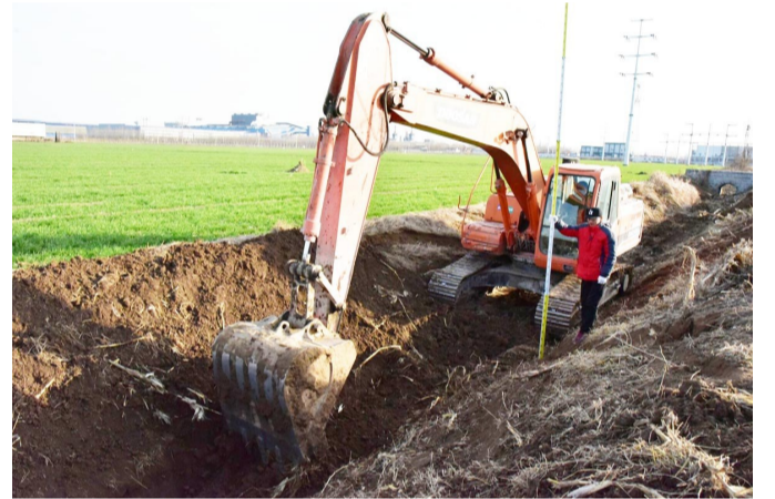
农田灌排渠系疏浚工程
