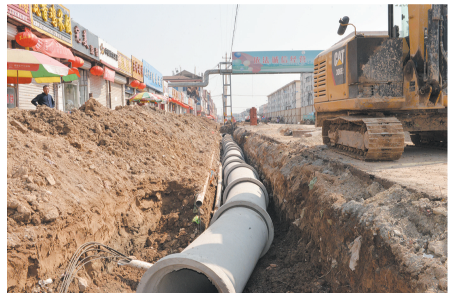
雨污水管网建设工程施工。
