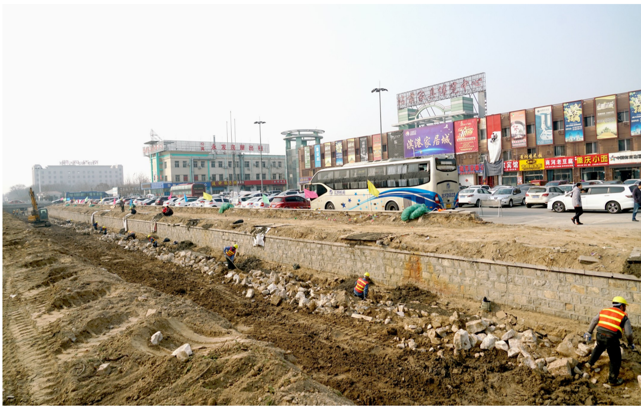
两侧驳岸毛石砌筑加固工程有序推进。
