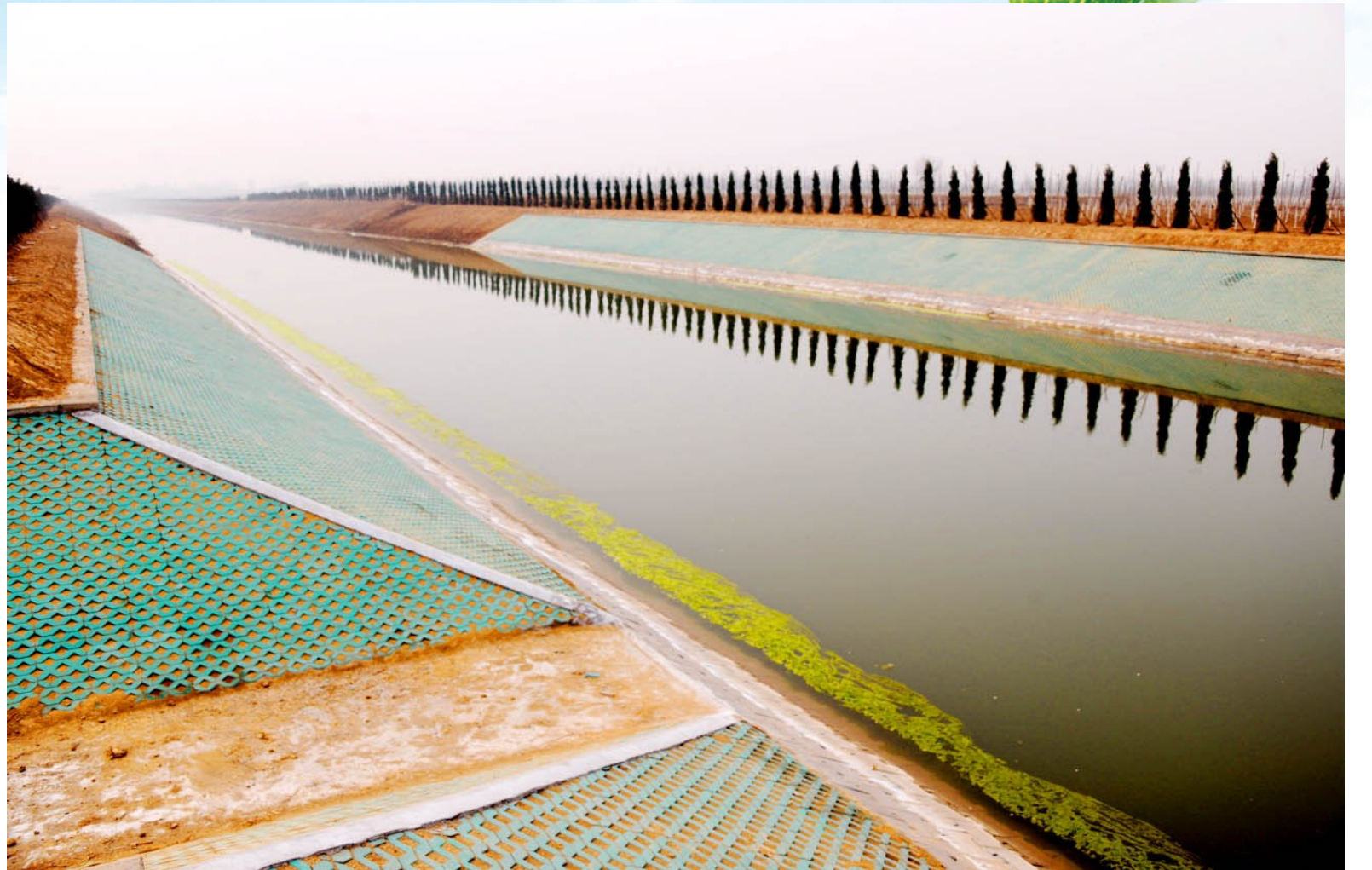
已经衬砌完成的新立河综合治理工程。
