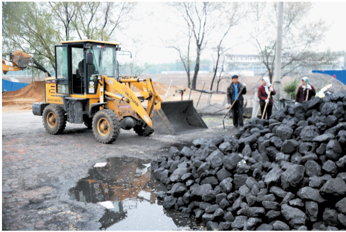
对沿河违规存放的煤炭、砂石进行搬离。
