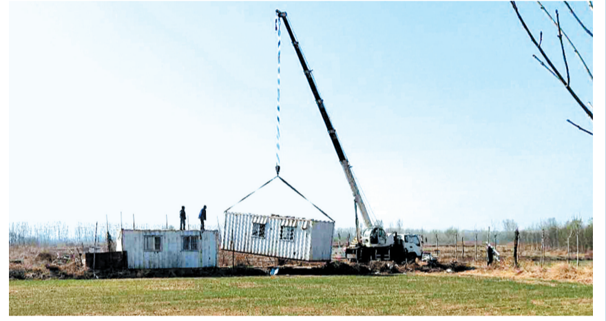
对沿河违建进行拆除。
