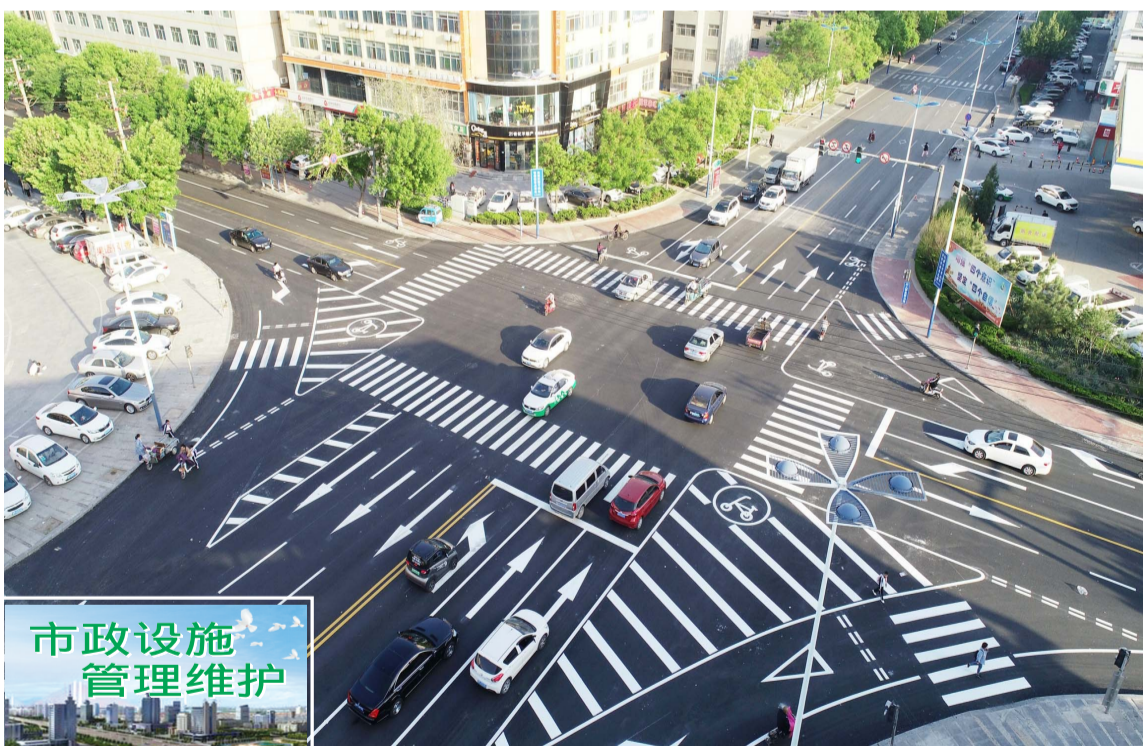
黄河三路渤海十路段细粒式沥青混凝土摊铺及道路标线已经完成。
