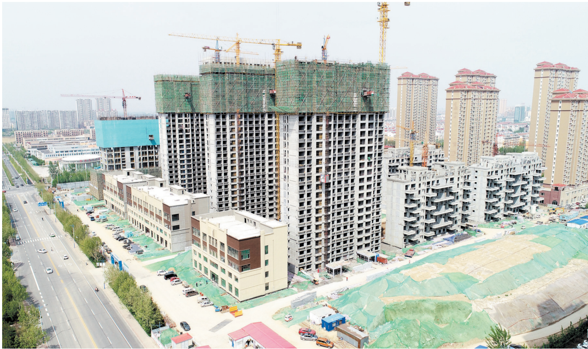
双泰·建大城在建项目航拍。
