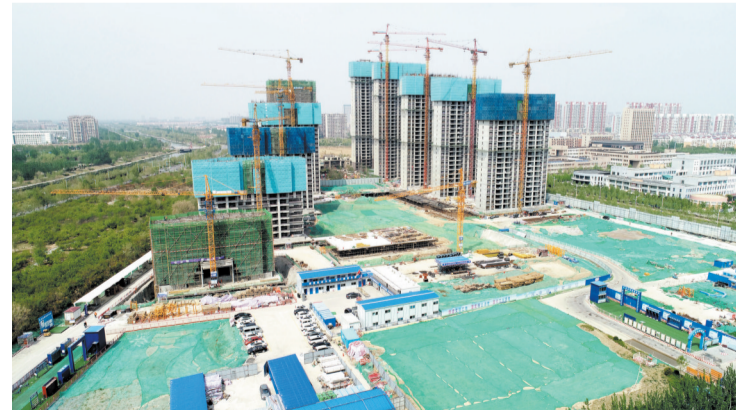
碧桂园·翡丽之光在建项目航拍。
