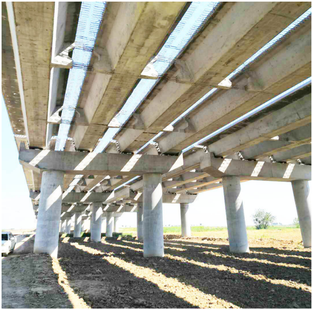
桥梁工程完成总量的29.38%
