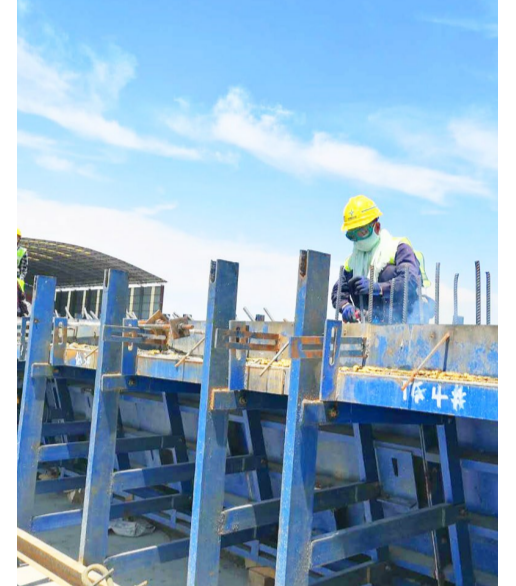
烈日当空,建设者在进行焊接作业
