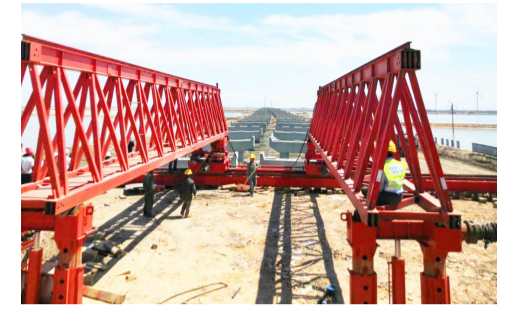
全长4379米的鲁北化工特大桥梁基本完成桩基工程,架梁机已经安装到位蓄势待发。
