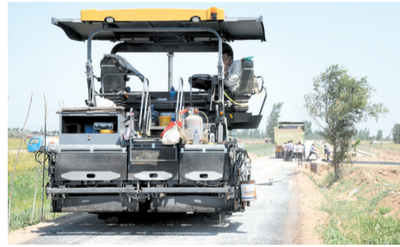
正在施工的田间道路。截至目前,工程已经全部竣工。
