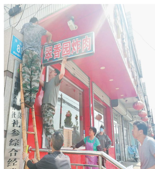
工作人员拆除广告牌,保证一户一牌。
