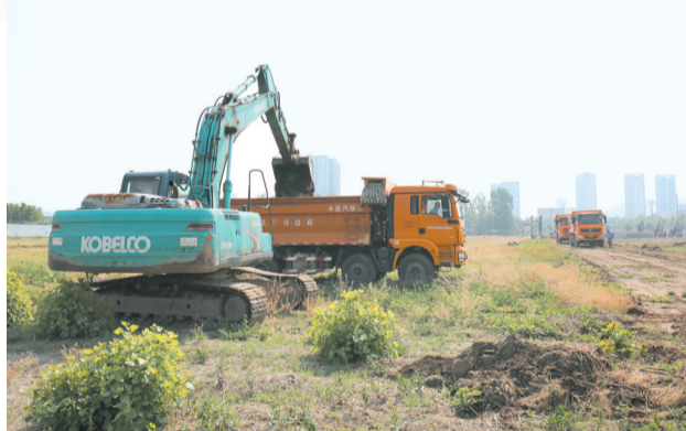
黛溪家园项目破土动工。
