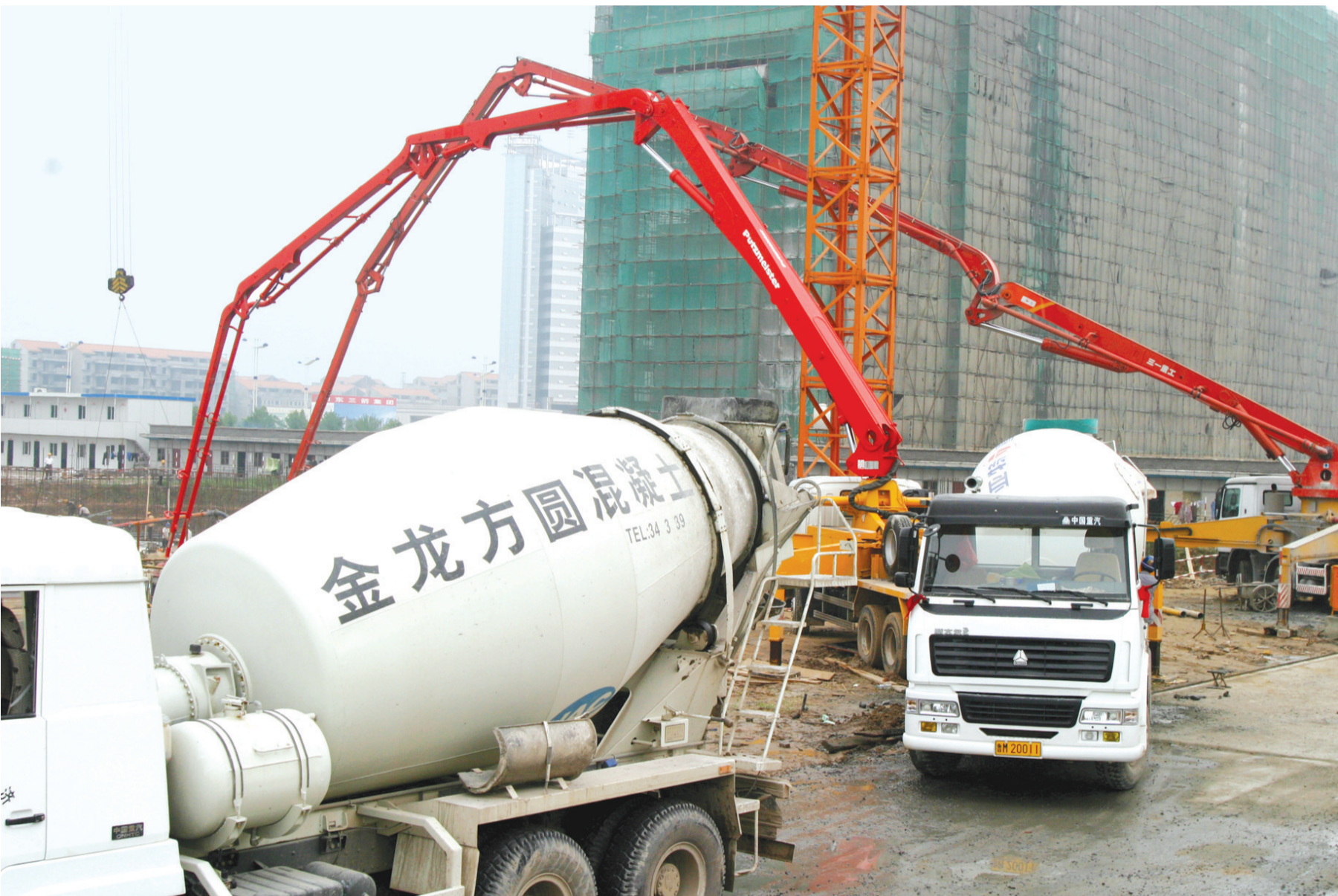
混凝土施工浇筑现场。
