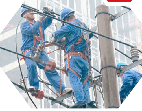
检修线路供电。
