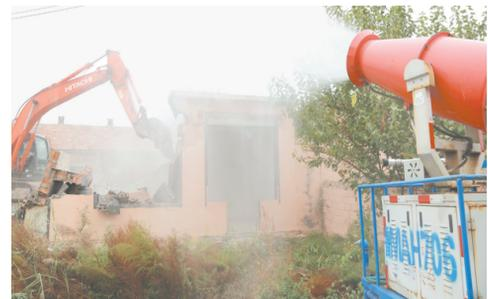
拆迁现场使用抑尘雾炮车进行降尘处理。
