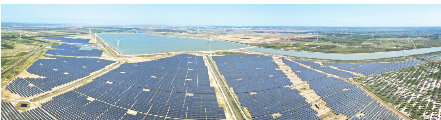
华能沾化清风湖200兆瓦风光同场项目
