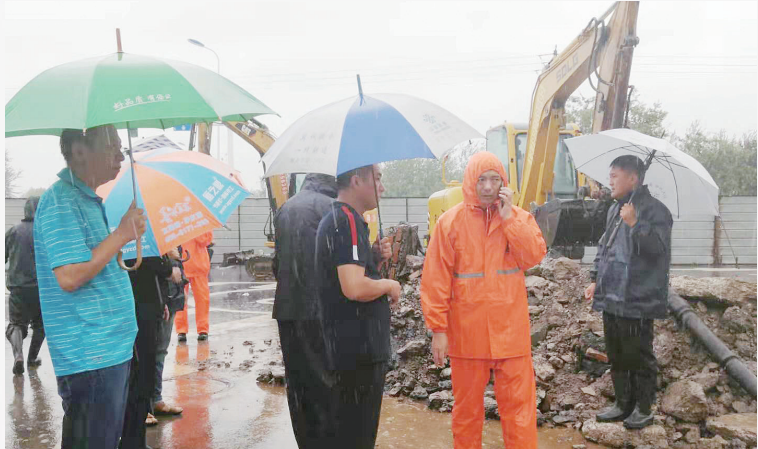
冒雨组织抢修管道
