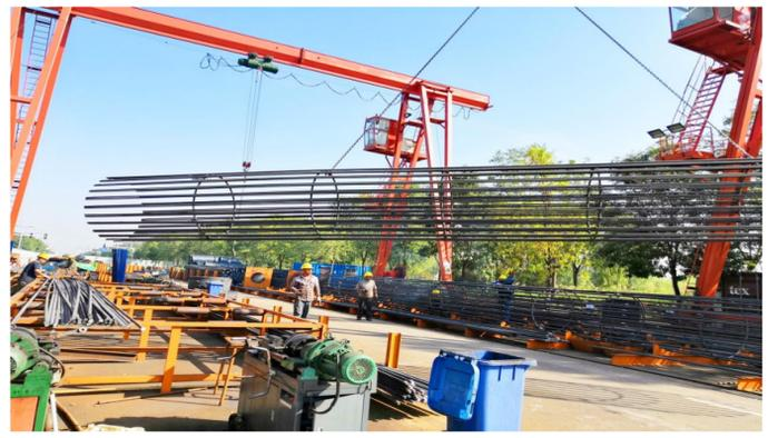
门吊在为巨大的钢筋笼转换工位
