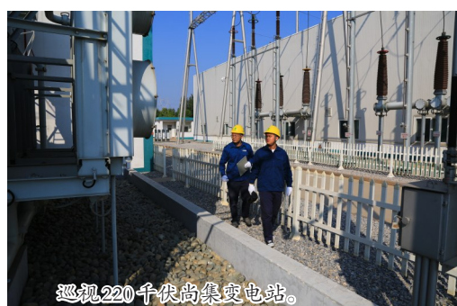
巡视220千伏尚集变电站。
