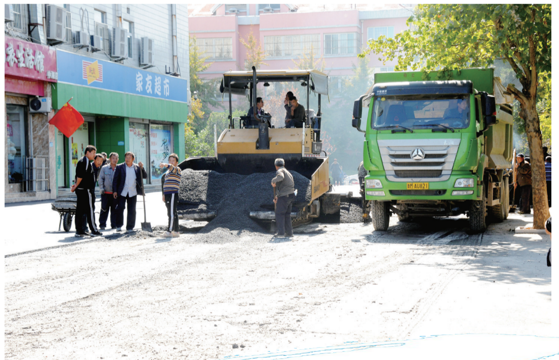
对周边道路进行整修。
