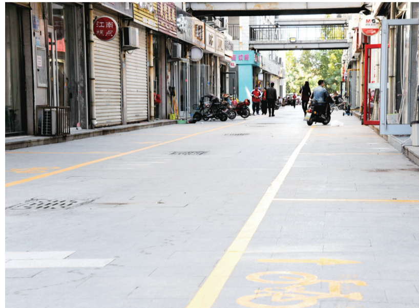
在广场中部商铺门口划出了非机动车停车位。
