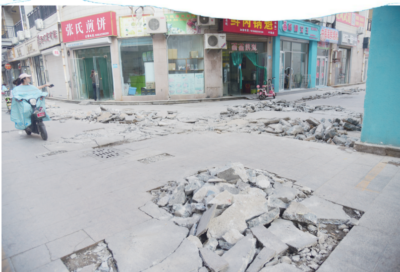
整修中的广场中部路面。
