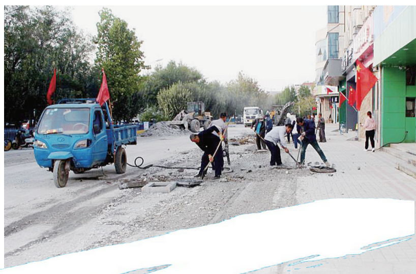
抬高井盖、雨水篦子。
