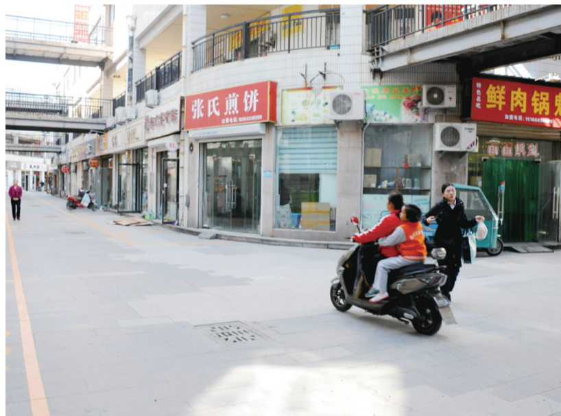
广场中部路面整修完成。
