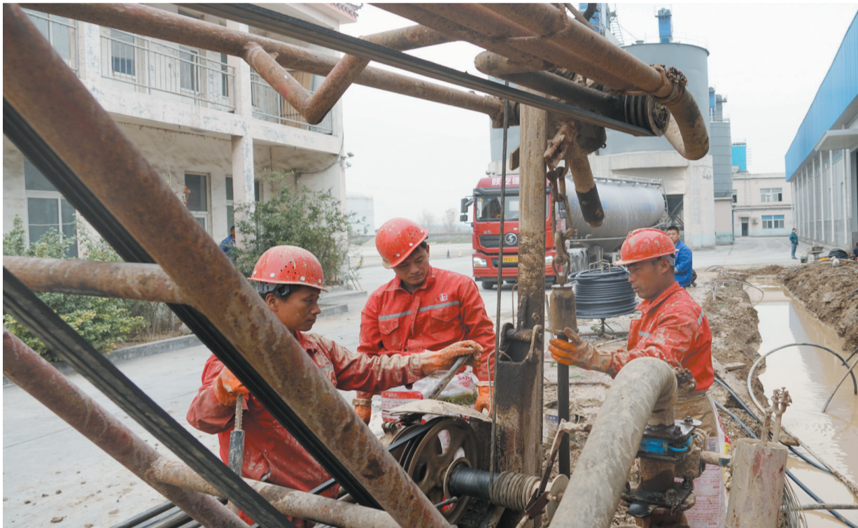
地源热泵项目打井施工中。
