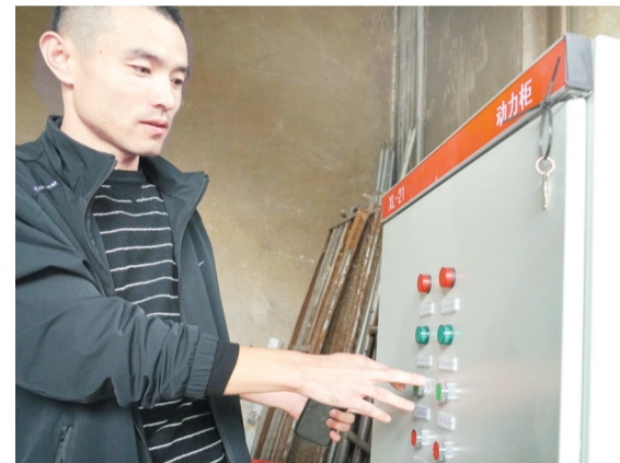
技术人员展示空气源热泵操作要领。
