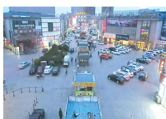
拆建前的渤海国际
