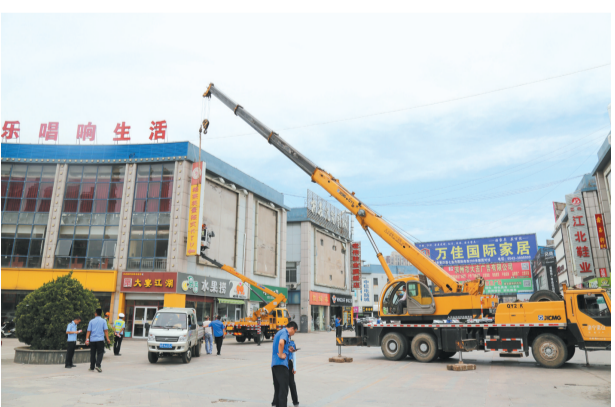
大型机械施工图
