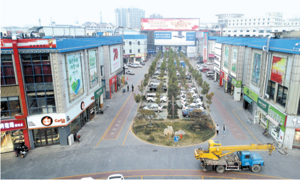
广告拆除后粉刷一新的楼顶
