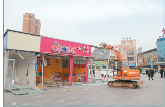
拆除小吃亭违建
