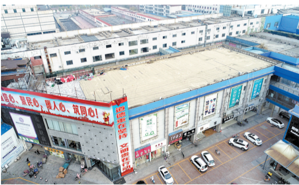
楼顶违建全部拆除
