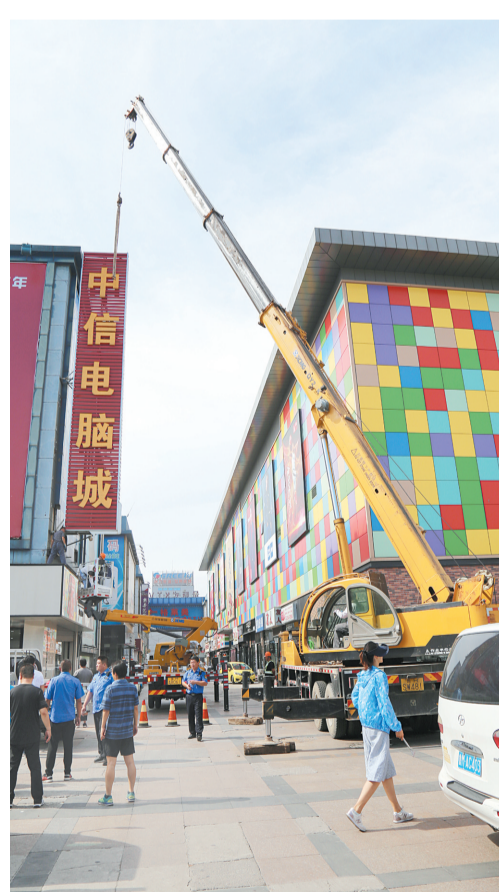
广告牌拆除中
