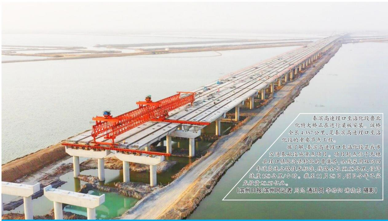
秦滨高速埕口至沾化段鲁北化特大桥正在进行梁板安装。该桥全长4.357公里，是秦滨高速埕口至沾化段的重要节点工程。据了解，秦滨高速埕口至沾化段是我市交通基础设施重点项目。项目起点位于无棣县埕口镇水沟堡村北的鲁冀界，全线采用双向四车道高速公路技术标准，线路全长60.68公里，设计时速120公里/小时。截至11月20日，项目今年已完成投资20.59亿元。(滨州日报/滨州网记者 周冕 通讯员 李皓阳 谢晓东 摄影)
