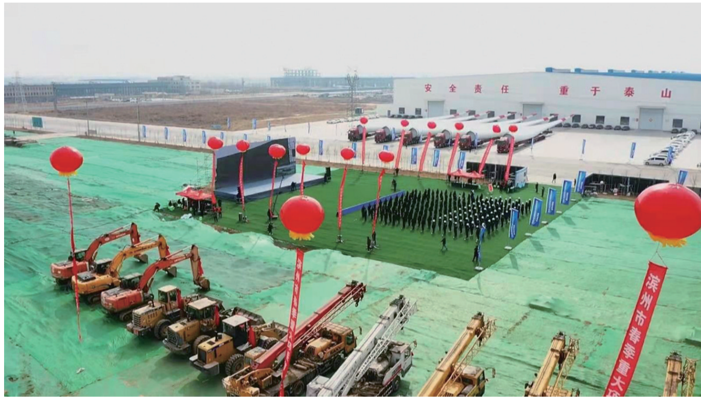
2月26日,全市春季重大项目集中开工仪式惠民分会场设在开发区润龙数控机床项目现场。
