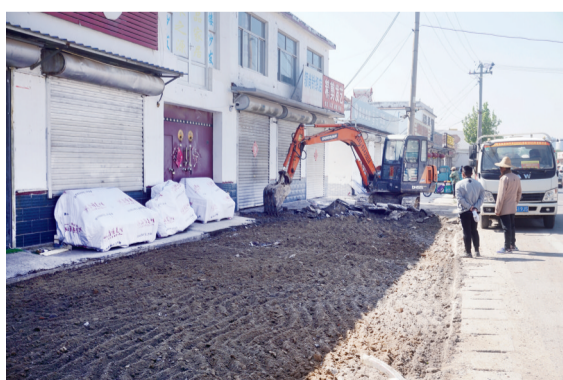
修整路边破损人行道。
