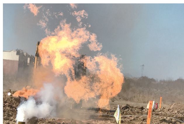
燃气输配管网“爆燃”。
