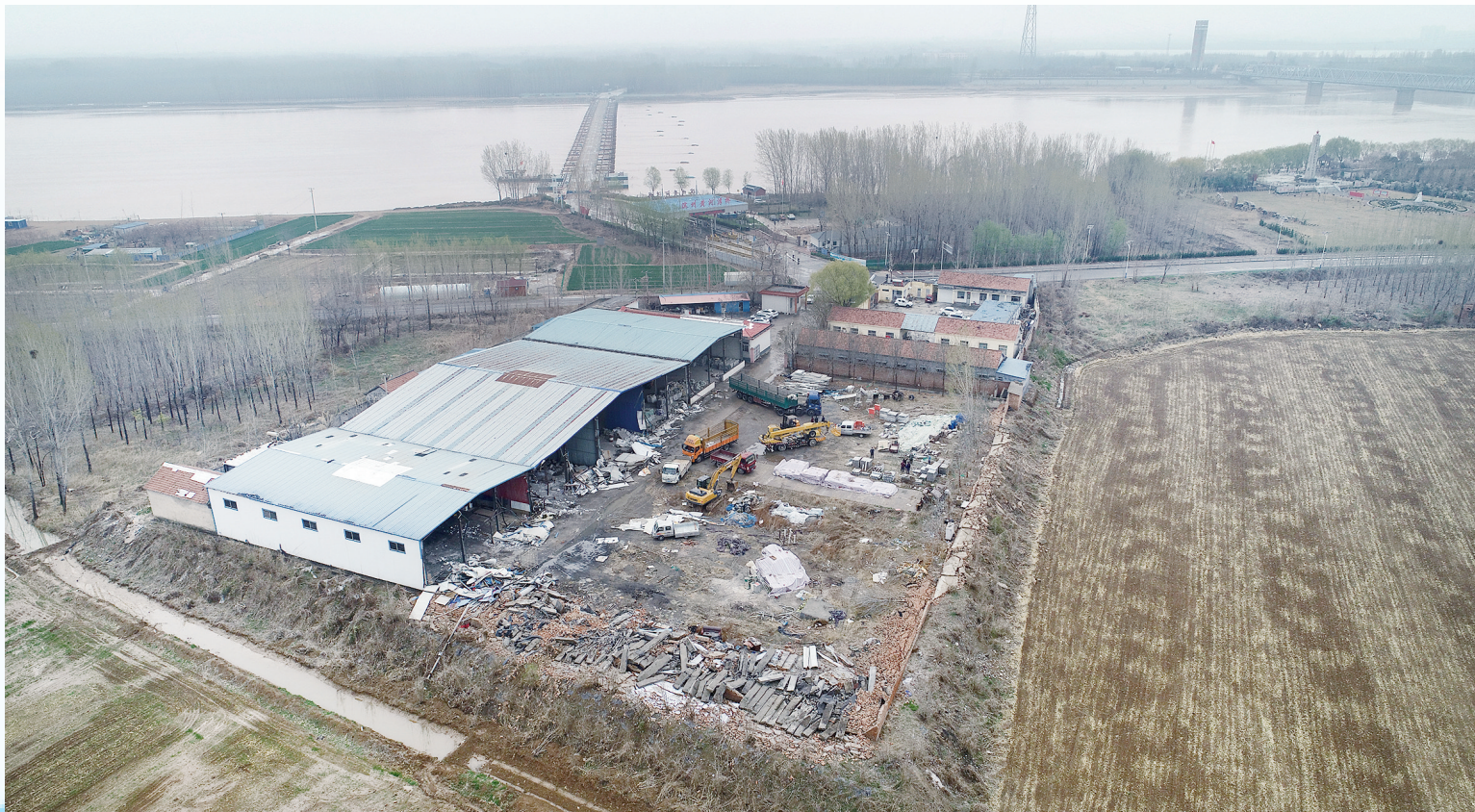
环通管业违建拆除现场。
