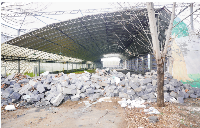
万绿大棚违建拆除现场。
