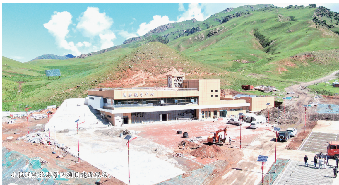
小拉洞峡旅游景区项目建设现场。
