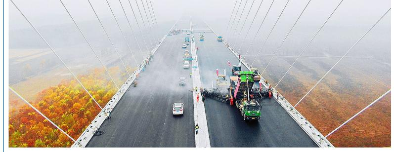
近日,由山东高速集团投资建 设的沾临黄河特大桥路面沥青摊 铺全部完成,为年底沾临高速通车 奠定坚实基础。
