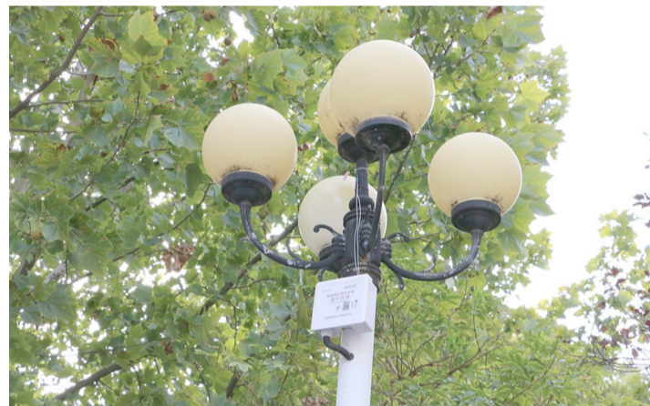
加装了物联网终端传感器的路灯。
