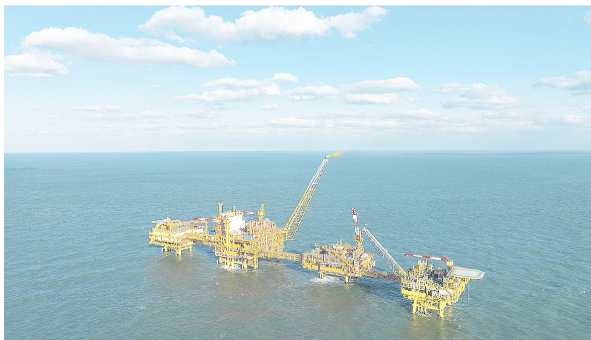
11月14日拍摄的渤中19-6气田(无人机照片)。(新华社 杜鹤辉 摄影)
