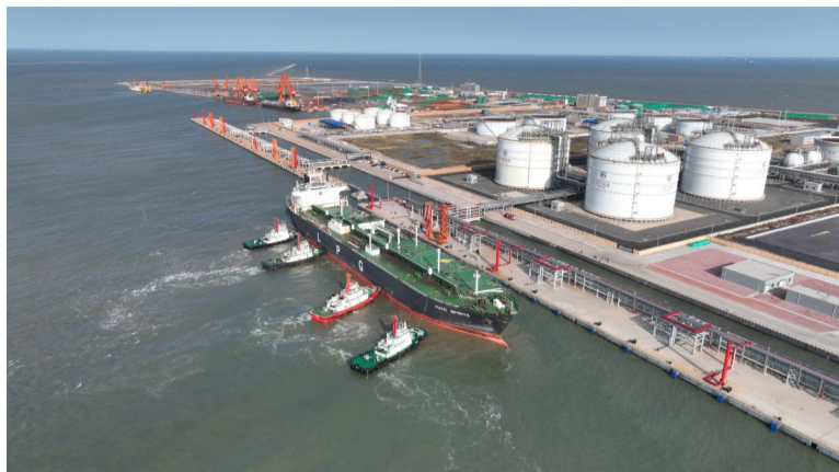
滨州边检站靠前服务,让口岸通关效率更便捷。
