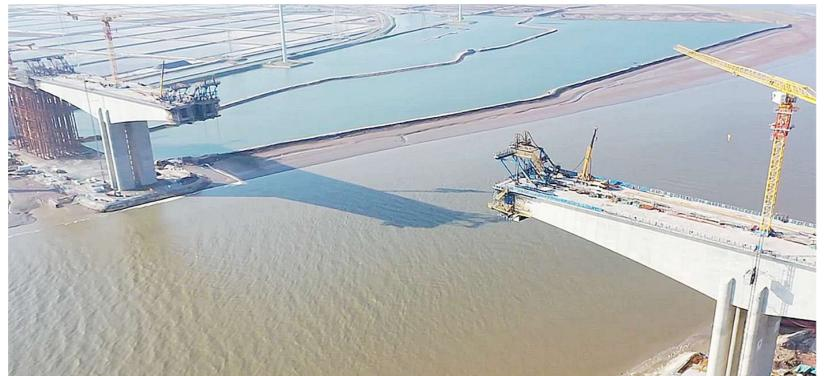
本报讯(记者 郭伟 报道)近日, 套尔河特大桥钢混结合段首节钢箱 梁顺利吊装完成,标志着套尔河特大 桥正式进入主桥合龙阶段。
